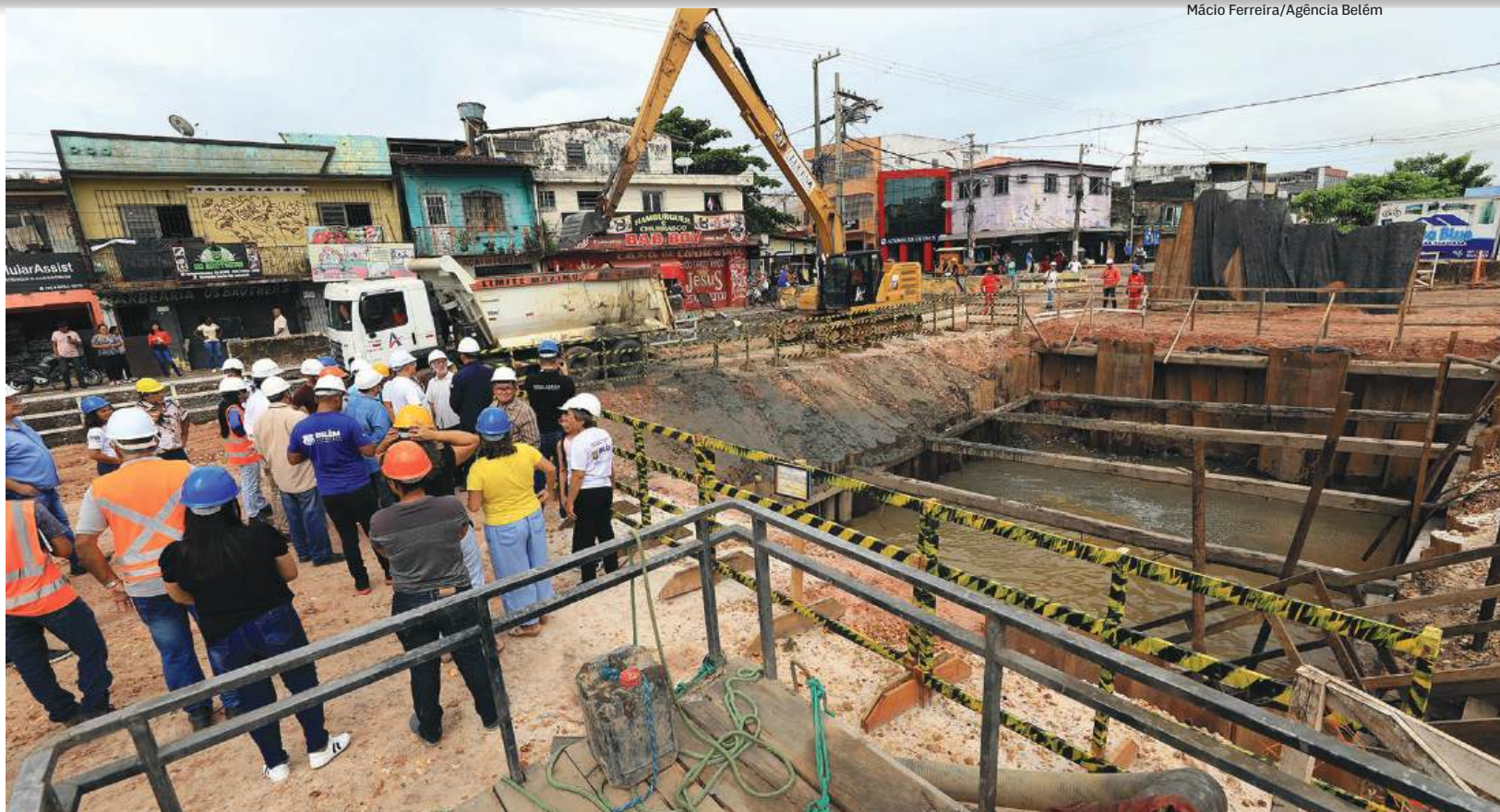
Conclusão das obras da primeira etapa está prevista para fevereiro de 2025
