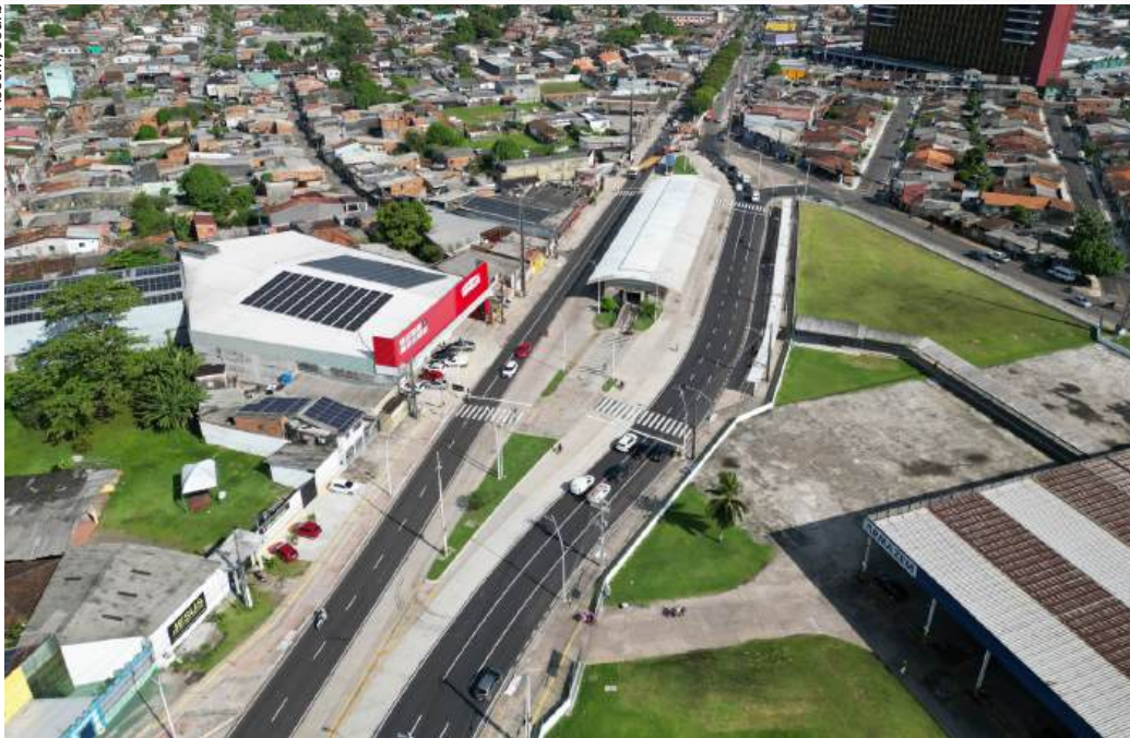
Avenida Augusto Montenegro: primeira fase de obras já concluída
