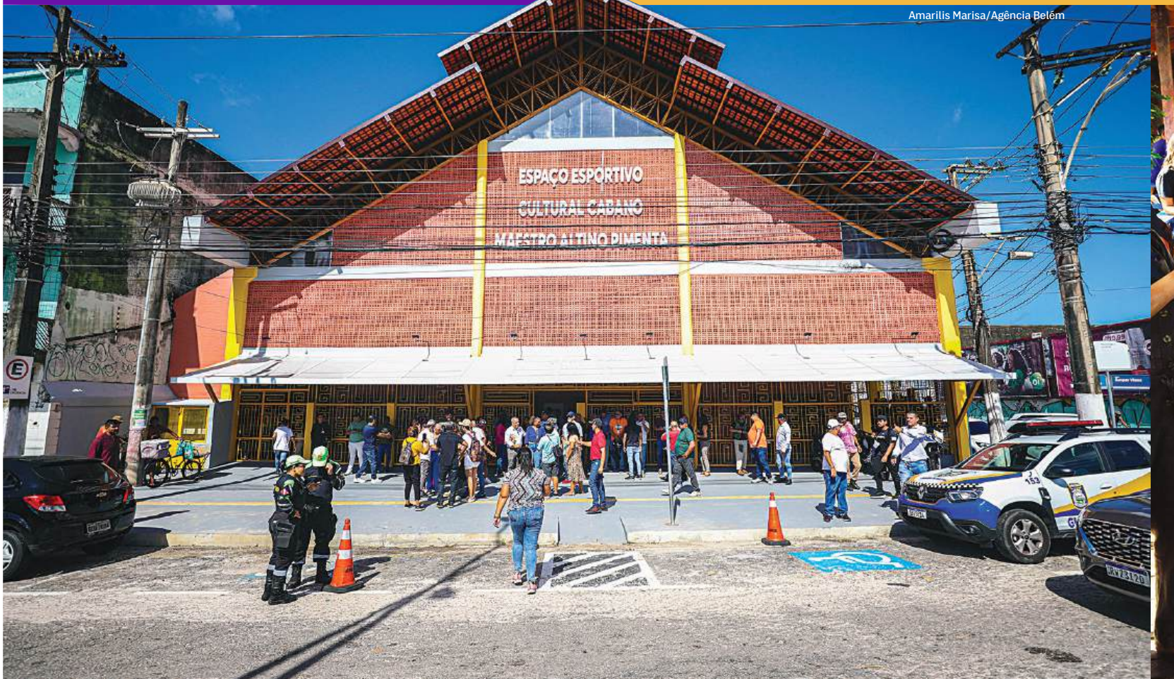
Espaço Esportivo Cultural Cabano “Maestro Altino Pimenta”, no bairro do Reduto
